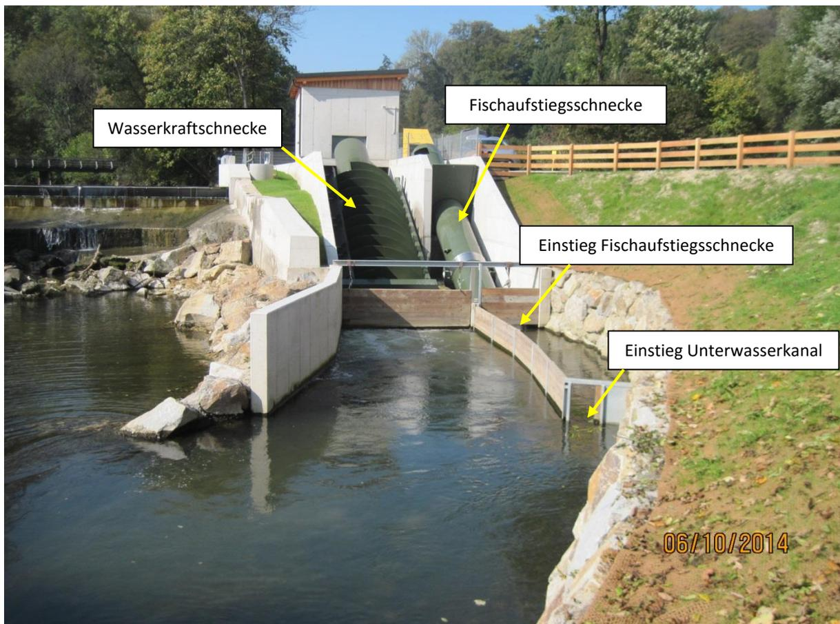
Während des Monitorings der Fischaufstiegsschnecke beim KW Pilsing an der Url sind im Herbst 2014 und Frühjahr 2015 an 104 Untersuchungstagen insgesamt 864 Fische aufgestiegen. Im Vergleichszeitraum sind über den oberhalb gelegenen Beckenpass Atzenhofer während 97 Tagen an denen die Reuse im Einsatz war, insgesamt 173 Fische aufgewandert.
