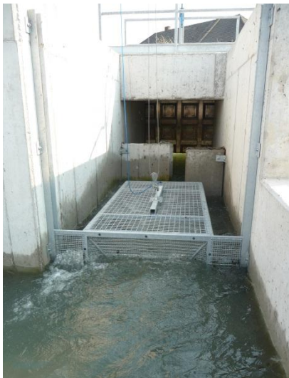
Abb.3: Reuse zur Kontrolle des Fischaufstieges
