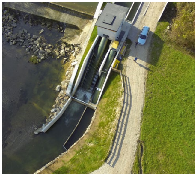
Bild 1: Wasserkraftschnecke mit getrennter FAS am Pilotstandort Pilsing der Fa. SGW (Quelle: SGW GmbH)
