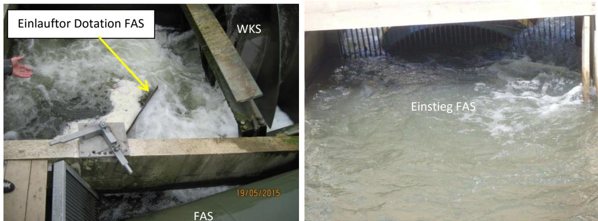
**Abb. 2 u. 3:** Dotationstor hinter der FAS (li) und unterwasserseitiger Einstieg in die FAS (re).
