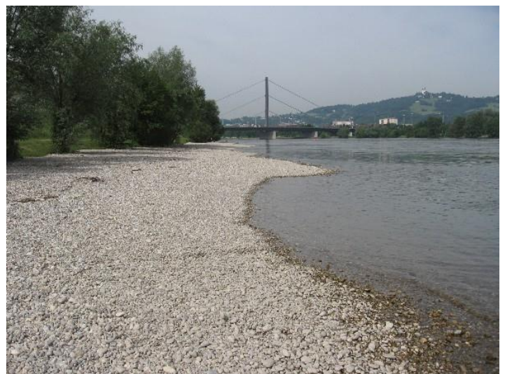
Abb.1 u. 2: Rechtes Donauufer unterhalb der Vöestbrücke in Linz vor und nach der Errichtung einer Schotterbank.
